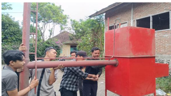
Gambar 6. Proses pemasangan incinerator
