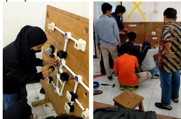
Gambar 6. Praktik pemasangan instalasi listrik
