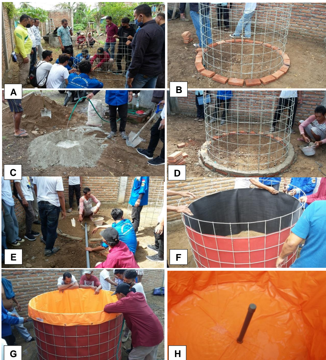
Gambar 3. Instalasi unit-unit bak terpal. Keterangan : A= Perakitan wire mesh sesuai ukuran diameter bak; B = Penempatan posisi rangka besi pada lokasi yang ditentukan; C = Persiapan adonan semen/pasir; D = Pemasangan bata penahan bak terpal; E = Pemasangan pipa saluran air; F = Pemasangan terpal pelapis; G = Pemasangan terpal utama; H = Pemasangan pipa penutup saluran air.
