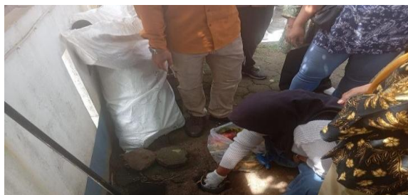
Gambar 3. Praktik Pembuatan Lubang Resapan Biopori dan cara memasukan sampah.
