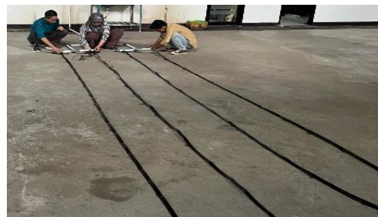
Gambar 3. Persiapan jaringan distribusi dan koneksi jaringan tetes.
