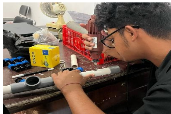
Gambar 2. Persiapan jaringan distribusi dan koneksi jaringan tetes
