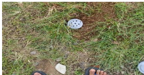
Gambar 4. Biopori yang sudah berhasil di pasang.
