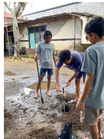
Gambar 2. Membuat lubang biopori
