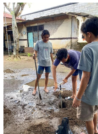
Gambar 2. Membuat lubang biopori
