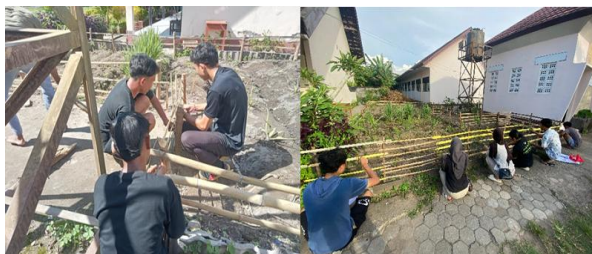
Gambar 6. Pemasangan dan Pengecatan Pagar
