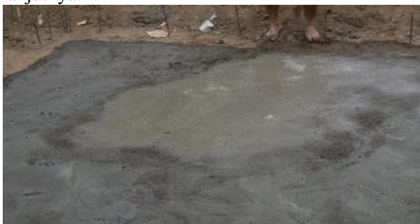
Gambar 12. Lantai Kerja Bak induk (Negara.dkk, 2017)
