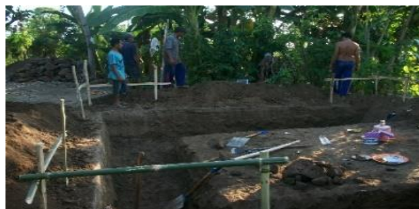
Gambar 8. Partisipasi warga dalam penggalian pondasi bak induk. (Negara.dkk, 2017)
