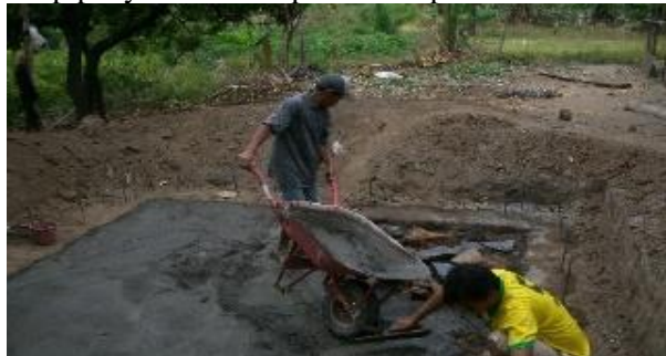
Gambar 11. Lantai Kerja Bak induk (Negara.dkk, 2017)
