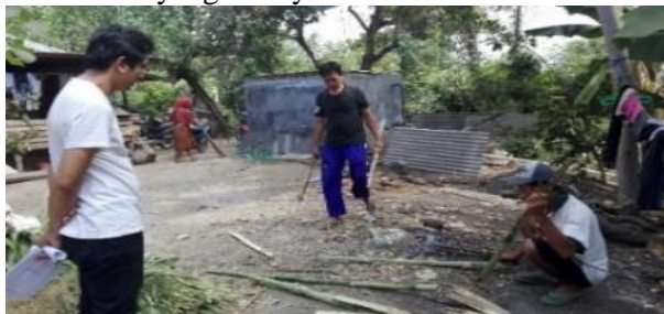
Gambar 6. Penyiapan patok. (Negara.dkk, 2017)
