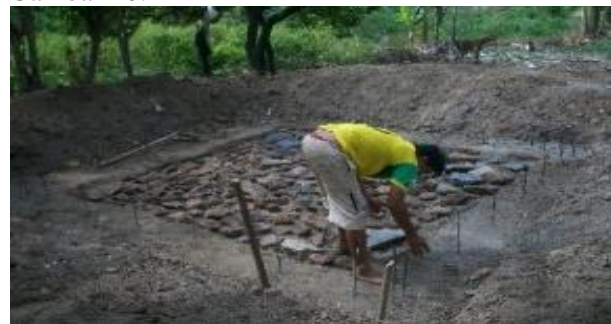
Gambar 10. Pemasangan Angker. (Negara.dkk, 2017)
