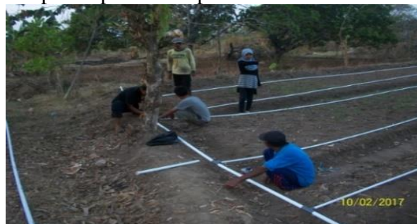
Gambar 5. Pemasangan Irigasi Tetes Pvc awal pada lahan Naga (Negara, dkk; 2017)
