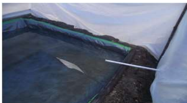
Gambar 7. Kondisi dempond yang sudah siap diisi air dari pipa pasokan air
