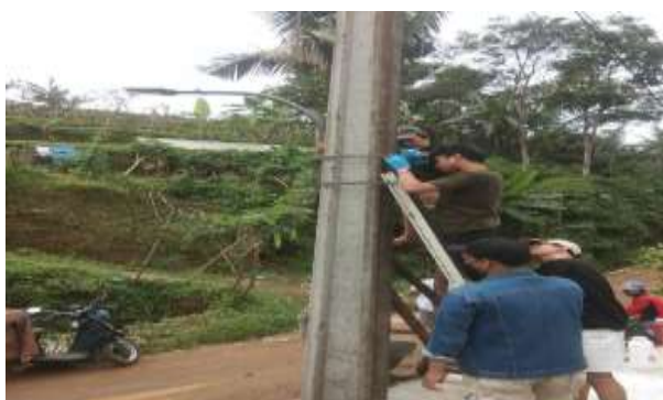
Gambar 5. Team melakukan pembuatan tiang penyangga lampu dan melakukan pemasangan lampu panel surya untuk jalan yang minim pencahayaan
