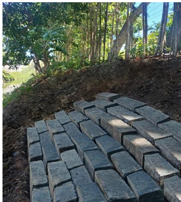
Gambar 5. Sampah Block sebagai alternatif pengendali erosi
