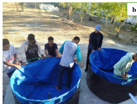
Gambar 3. (a) Kegiatan pembuatan alas kolam berupa beton, (b) Perakitan dan pemasangan kolam wermesh.
