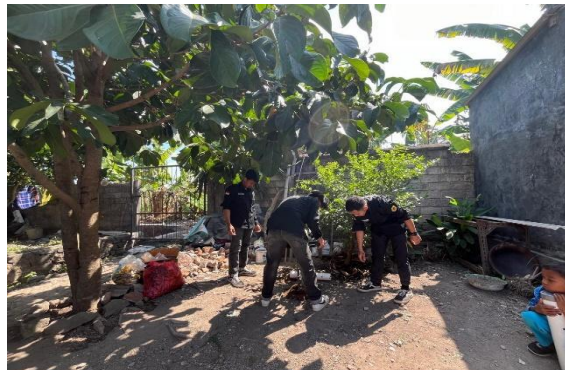
Gambar 4. Penanaman Pipa Biopori di Salah Satu Rumah Warga
