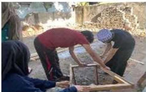
Gambar 3. Membentuk Kerangka Tempat sampah Kerangka tempat Sampah.
