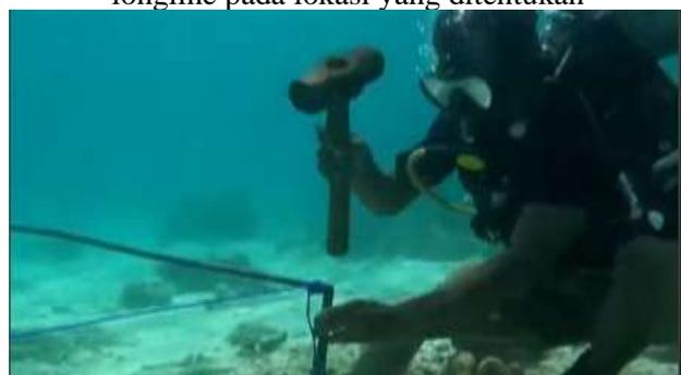
Gambar 11. Penancapan patok menggunakan palu besi
