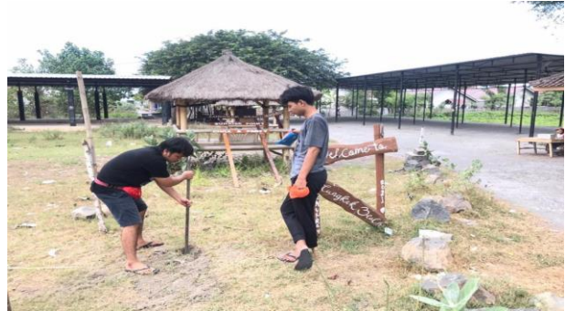
Gambar 14. Proses penggalian lobang untuk pemasangan papan penanda jalan dan papan informasi
