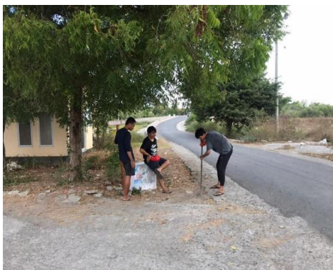
Gambar 16. Pemasangan papan penanda jalan
