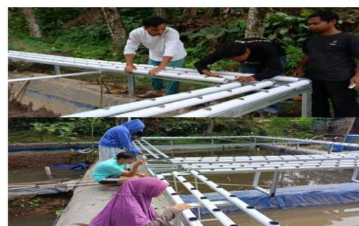
**Gambar 4.** Instalasi Sistem Akuaponik pada Kolam Ikan
