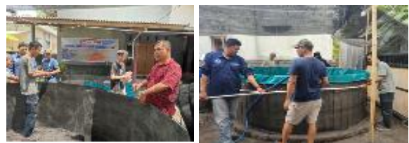
Gambar 2. Pemasangan kolam terpal dan instalasi pendukungnya
