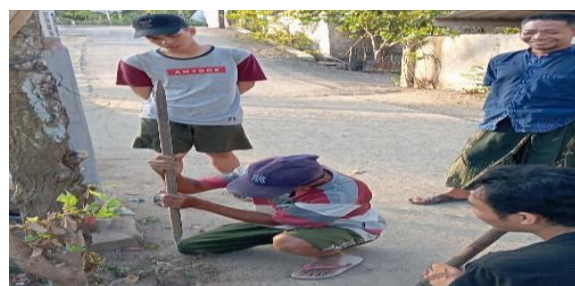
Gambar 2.2 Pembuatan lubang biopori untuk sampah limbah rumah tangga
