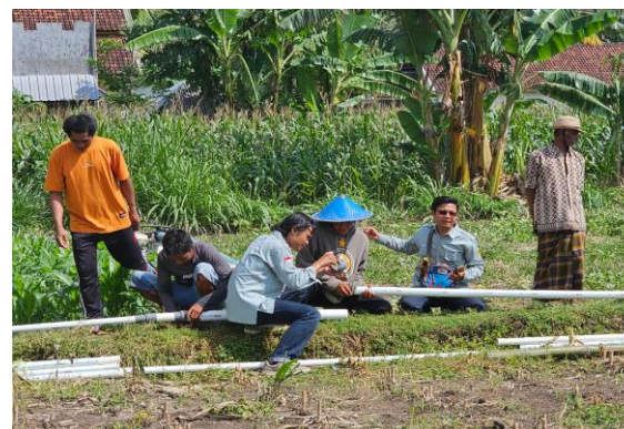
Gambar 4. Merangkai Alat Jaringan Pipa Irigasi Springkler
